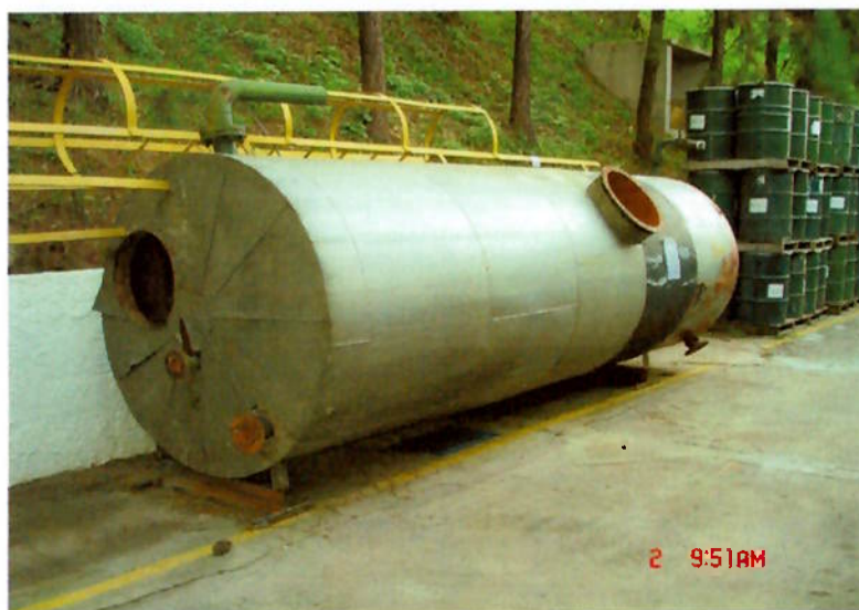
Foto 11. Tanque em aço carbono apoiado em berços de madeira
