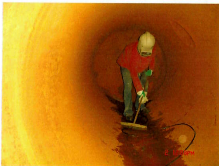
Foto 14. Trabalhador com “escafandro” preparando a superfície para jateamento com granalha de aço
