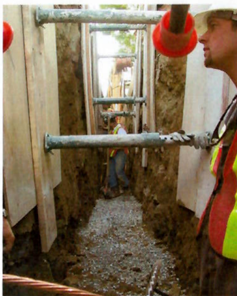
Foto 4. Vala - escoramento das paredes. Fonte: Apresentação Mc Manus, 2006
