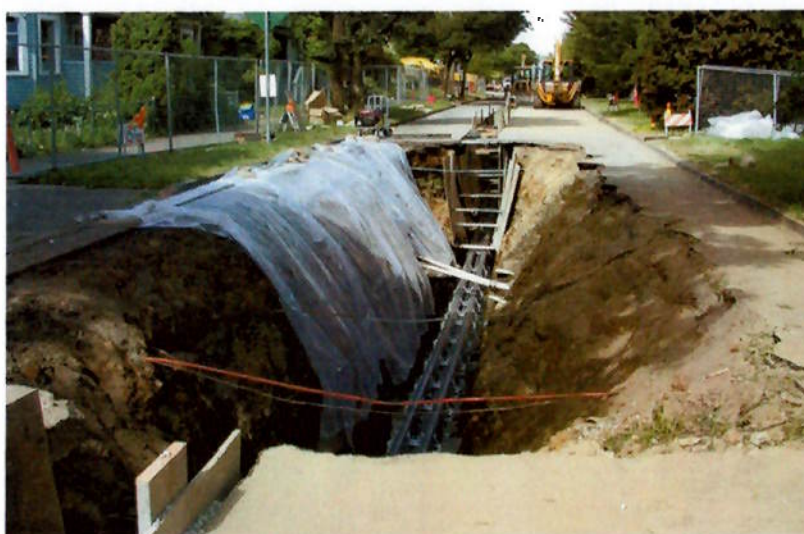
Foto 5. Vala - escoramento das paredes e proteção do talude. Fonte: Apresentação Mc Manus, 2006
