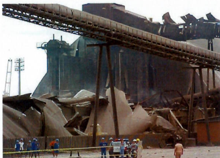
Foto 3. Danos provocados pela explosão de poeira no terminal graneleiro de Paranaguá – PR – nov. 2001
