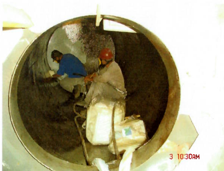
Foto 17. Aplicação da manta de fibra de vidro
